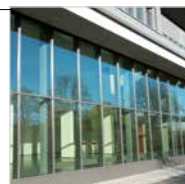
Erweiterungsbau Zentrum für Datenverarbeitung Errichtet mit nachwachsenden Rohstoffen 5,6 Millionen Euro 2013
