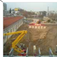
Baubeginn der MESA-Beschleunigerhalle 1. Teilbaumaßnahme des neuen Centrums für Fundamentale Physik (CFP I), Fertigstellung 2022 28,7 Millionen Euro 2019
